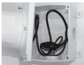
Расположите кабели и закройте коммутационную коробку
