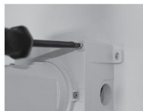
Закрутите винты коммутационной коробки
