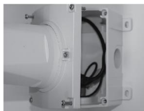
Расположите кабели и закройте коммутационную коробку
